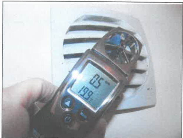
Fot. 06. Pomiar przepływu powietrza przy kratce wentylacyjnej (kuchnia).
