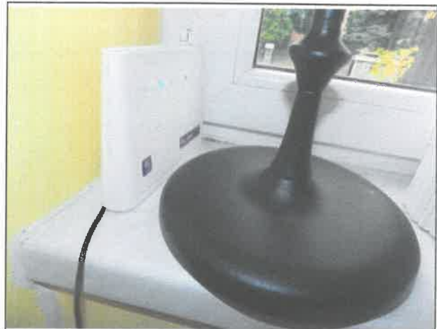
Fot. 12. Nie wielkie ogniska korozji biologicznej przy stolарce okiennej (pokój nr 2).
