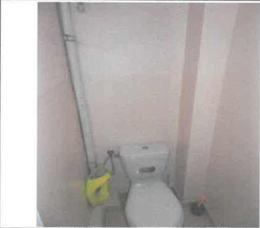
Fot. 13. Pomieszczenie WC znajduje się w dostatecznym stanie technicznym.
