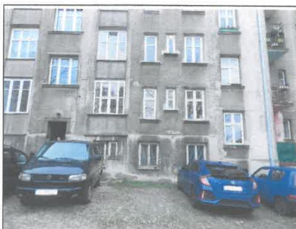
Fot. 02. Widok ogólny budynku elewacja północno-wschodnia.
