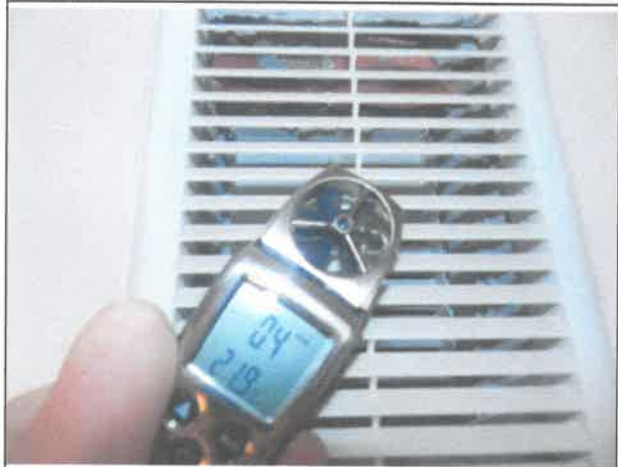
Fot. 14. Pomiar przepływu powietrza przy kratce wentylacyjnej pomiędzy WC oraz łazienką.
