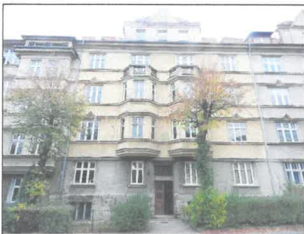
Fot. 01. Widok ogólny budynku elewacja południowo-zachodnia.
