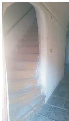
SCHODY NA PODDASZE
