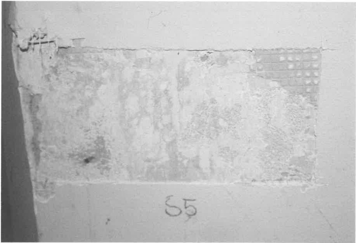
SIEŃ – PRÓBKA 5 - ŚCIANA
