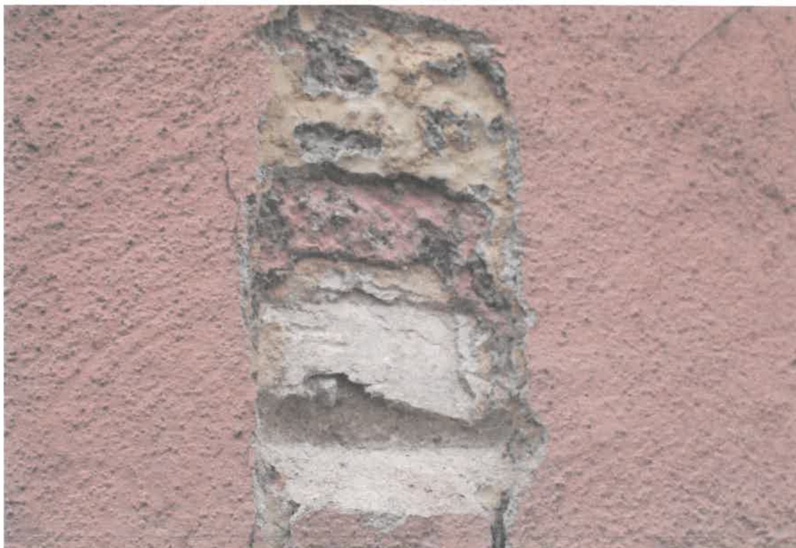
ELEWACJA OD UL. 11 LISTOPADA – PRÓBKA 3 – OPASKA POŁA Z KARTUSZEM NA POZIOMIE I PIĘTRA
