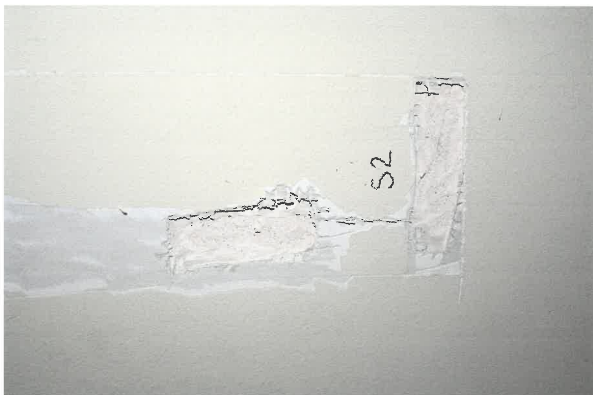
SIEŃ – PRÓBKA 2 - SKLEPIENIE
