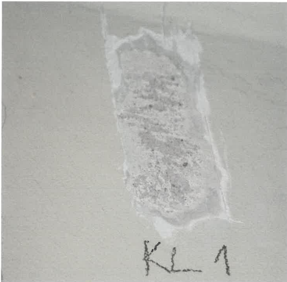
KLATKA SCHODOWA – PRÓBKA 1 – ŚCIANA I SKLEPIENIE
