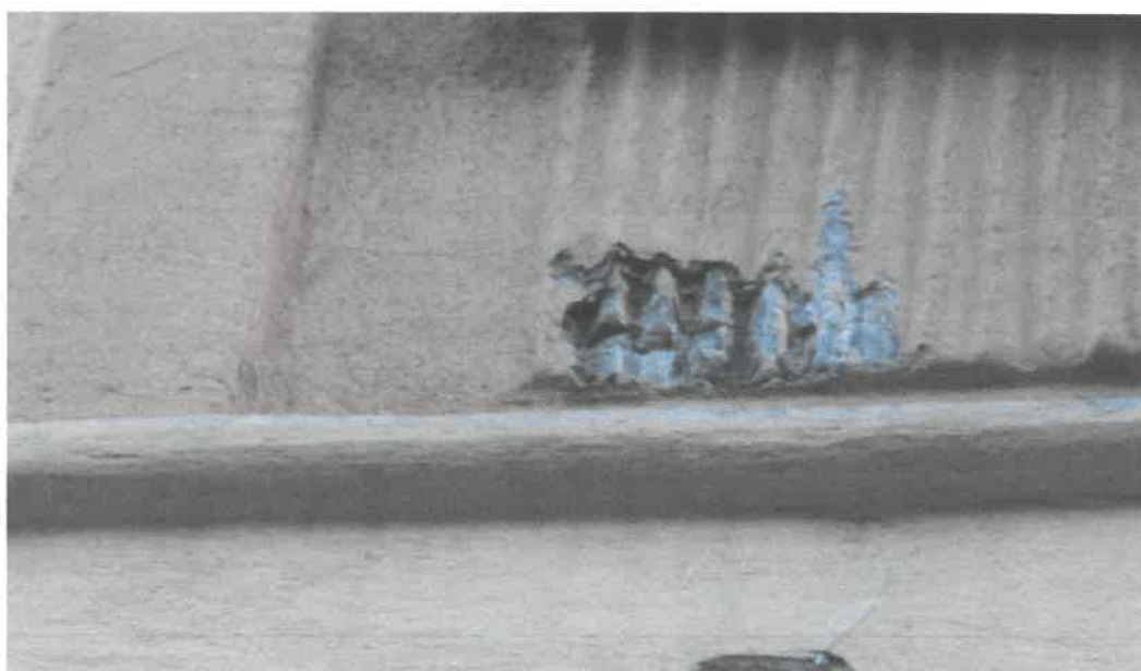
ELEWACJA OD UL. 11 LISTOPADA – PRÓBKA 6 – OPASKA DRZWIOWA Z TYNKU KAMIENIARSKIEGO W PRZYZIEMIU
